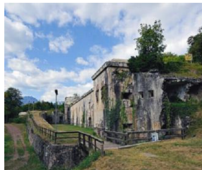
Sarà il forte di Valledrane di Treviso Bresciano a ospitare l'incontro
